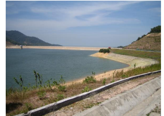
Teluk Bahang Dam
